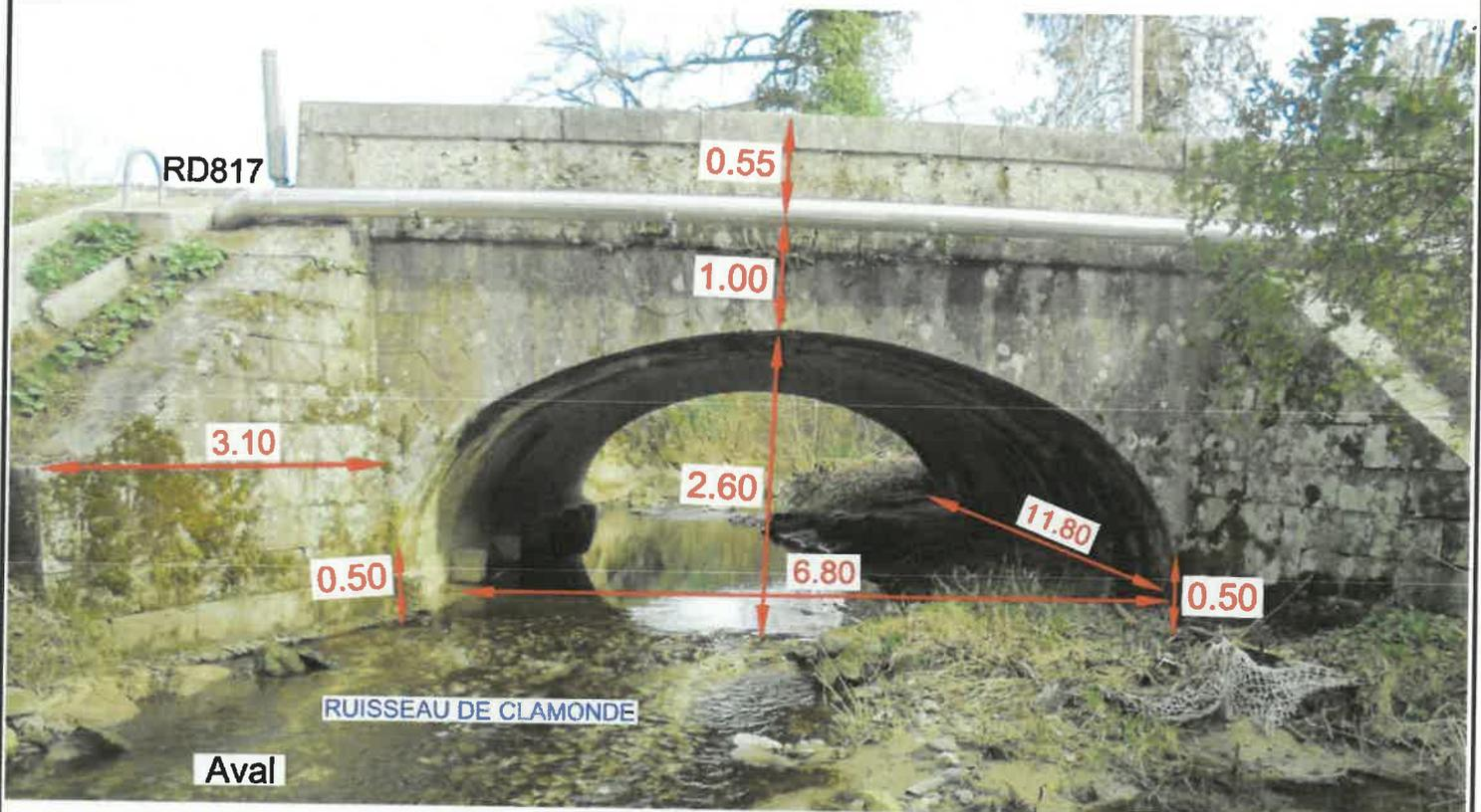
**CASTETIS - Travaux d'entretien : injection localisée de béton
