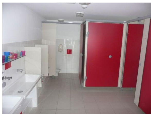
Sanitaires école refaits à neuf
